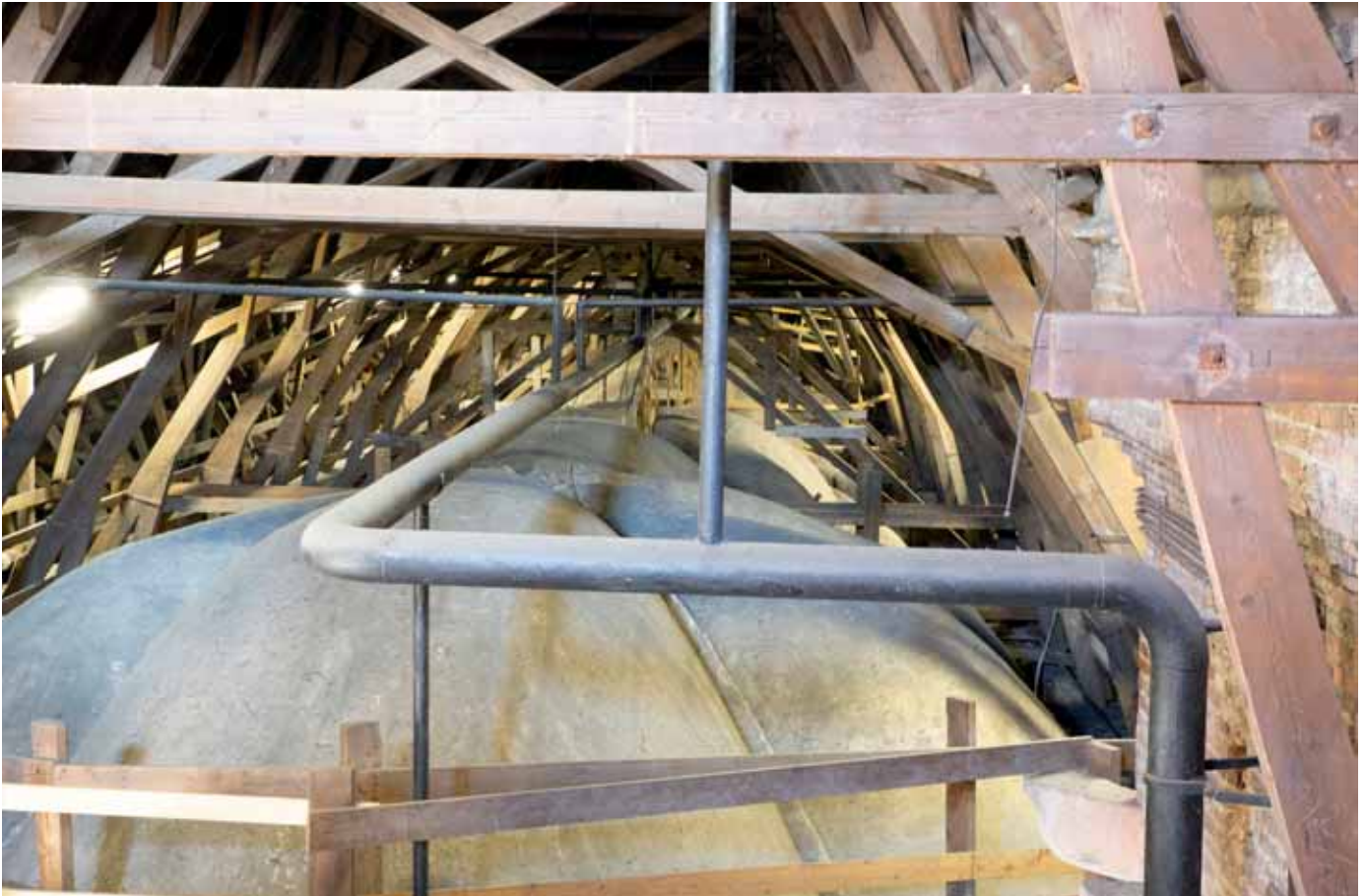
Sprinklernet boven gewelven van de Lebuïnuskerk in Deventer.
