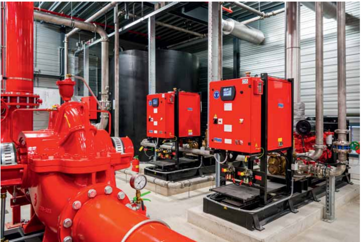
De toerendrukregeling zorgt er voor dat de sprinklerpompsets efficiënter functioneren.
