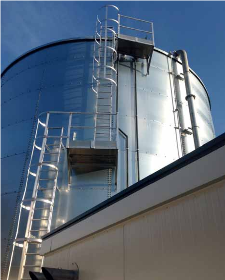
Het bluswater van een sprinklerinstallatie is vaak opgeslagen in sprinklertanks.
