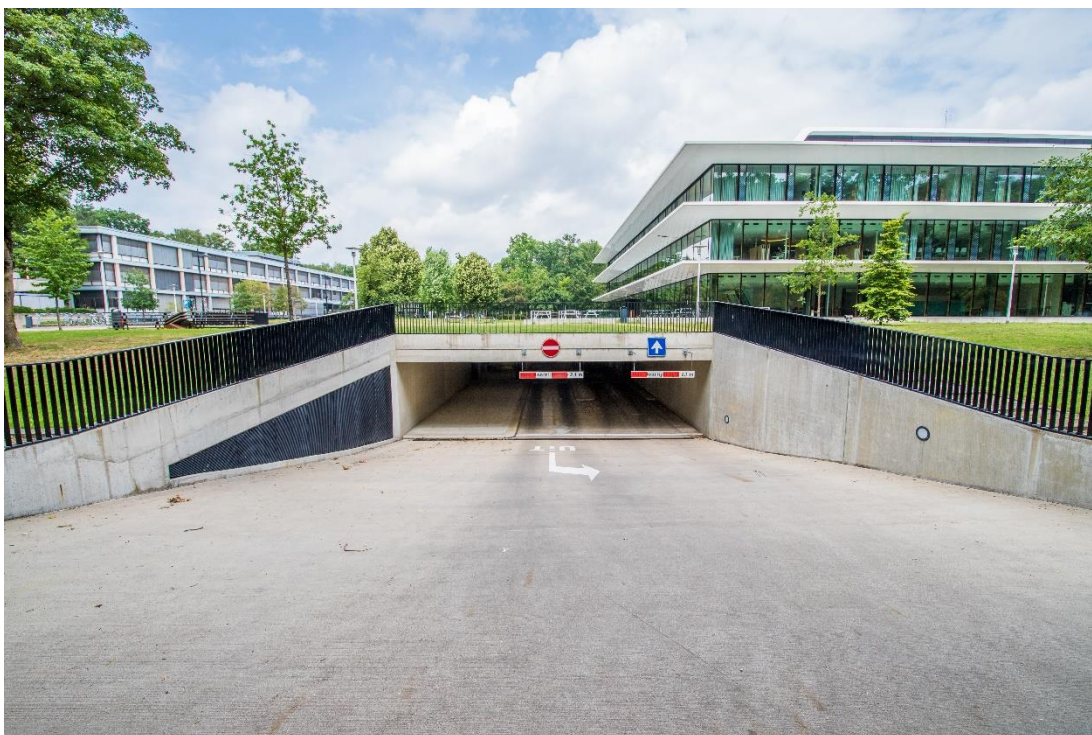
Afbeelding 5.4 Ondergrondse parkeergarage (bron: Tom Hessels, IFV)
