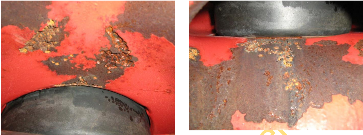
Figuur 11: Cavitatieschade PSV.
