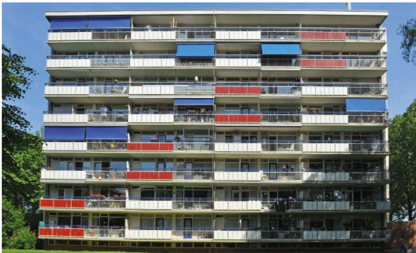
Schouwlaak in Zutphen is voorzien van een woningsprinklerinstallatie.
